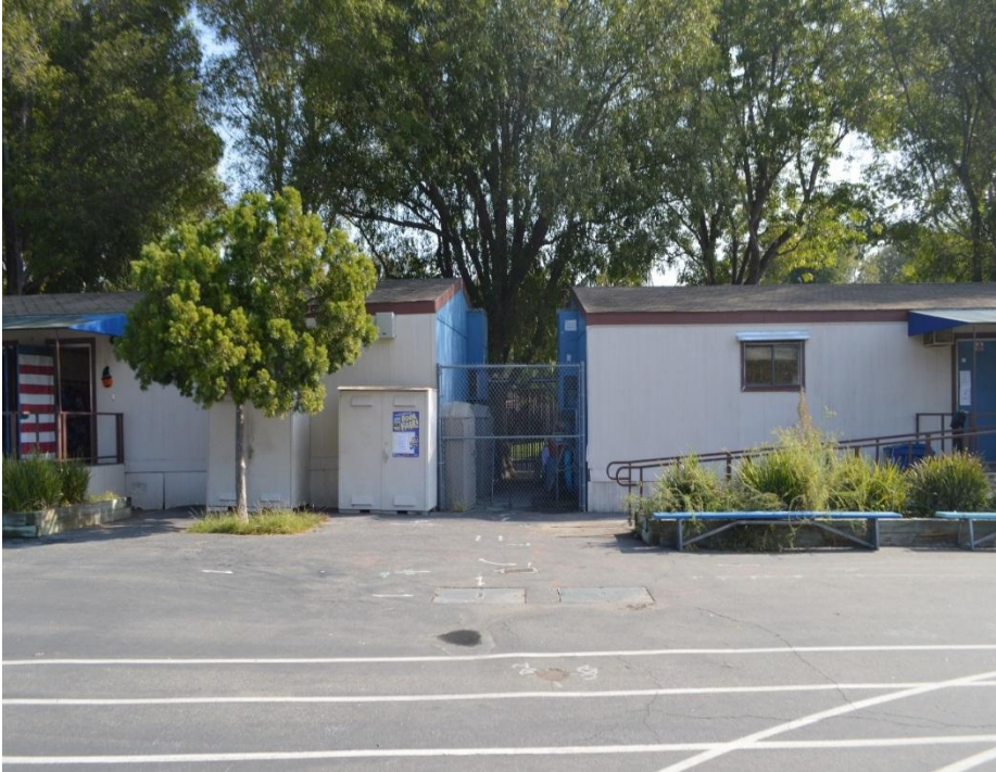
Two (2) existing DOH buildings to be removed Dos (2) edificios de DOH que se retirarán
